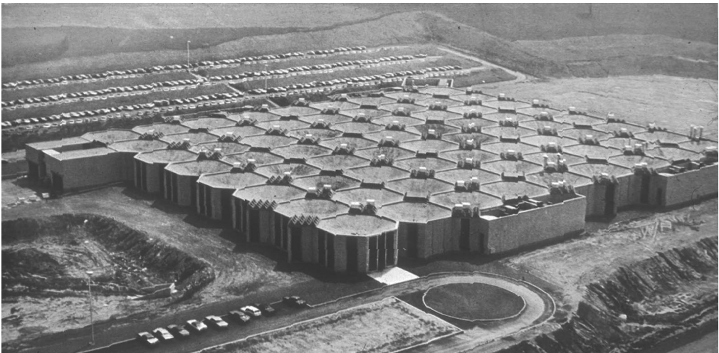
Figure 1. Olivetti-Underwood factory, Harrisburg (PA), 1970. Architect, L.I. Kahn; Engineer, A. Komendant. (Associazione Archivio Storico Olivetti)
